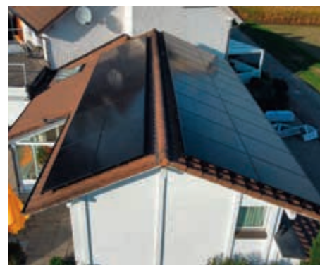
Im Einlegersystem montierte Module werden zum Schluss in die fertige Dachkonstruktion eingelegt.
