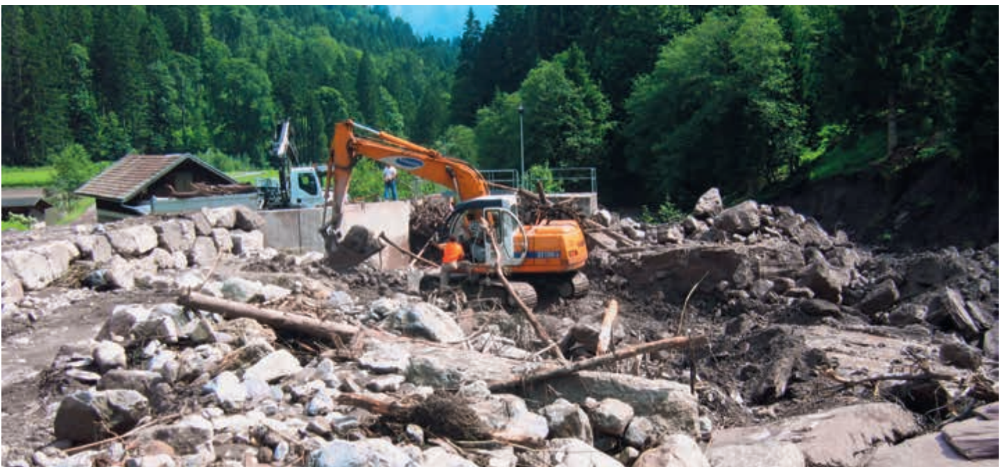
Abbruch der alten Wasserfassung beim Kraftwerk Schils.
