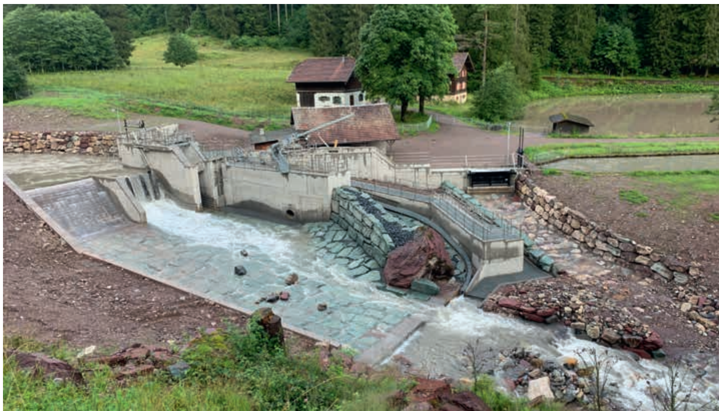
Kraftwerk Schils mit neuer Wasserfassung, für Fische und Sedimente passierbar.
