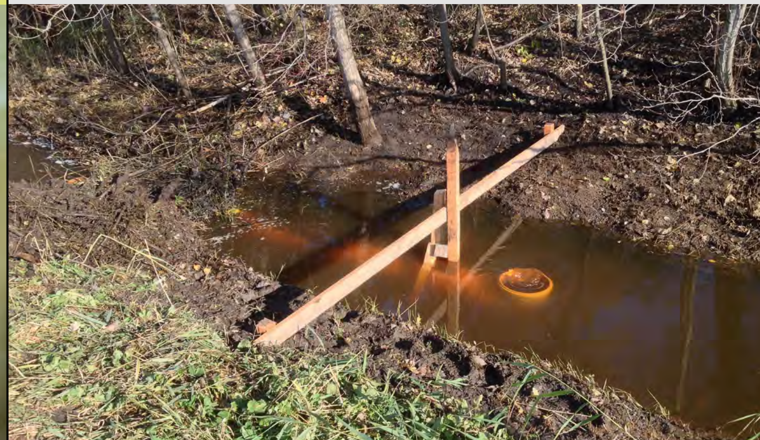
Ein Rohr, das durch den Biberdamm gesteckt wird, sorgt dafür, dass der Wasserspiegel nicht zu hoch ansteigt. Ein guter Kompromiss!
