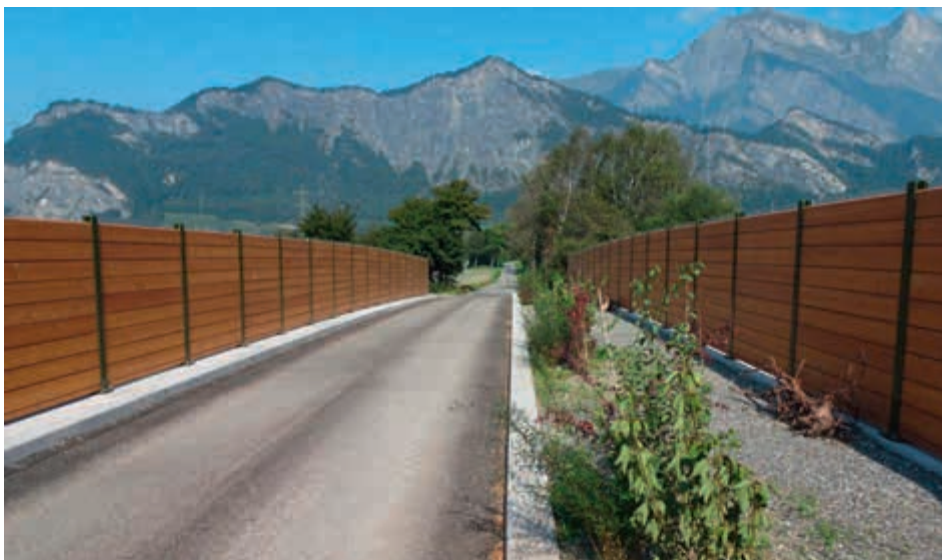
Wird ein Korridor mit speziellen Bauwerken versehen, spricht man von Wildtierpassagen, wie hier in Bad Ragaz auf der Freihofbrücke.
