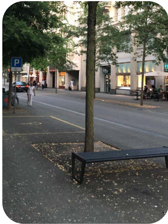
↑ Ungünstig für den Baum: Wurzelbereich abgedeckt mit Sickerasphalt oder Baumschutzrost. (Poststrasse 2021, Foto: GSI Architekten)
