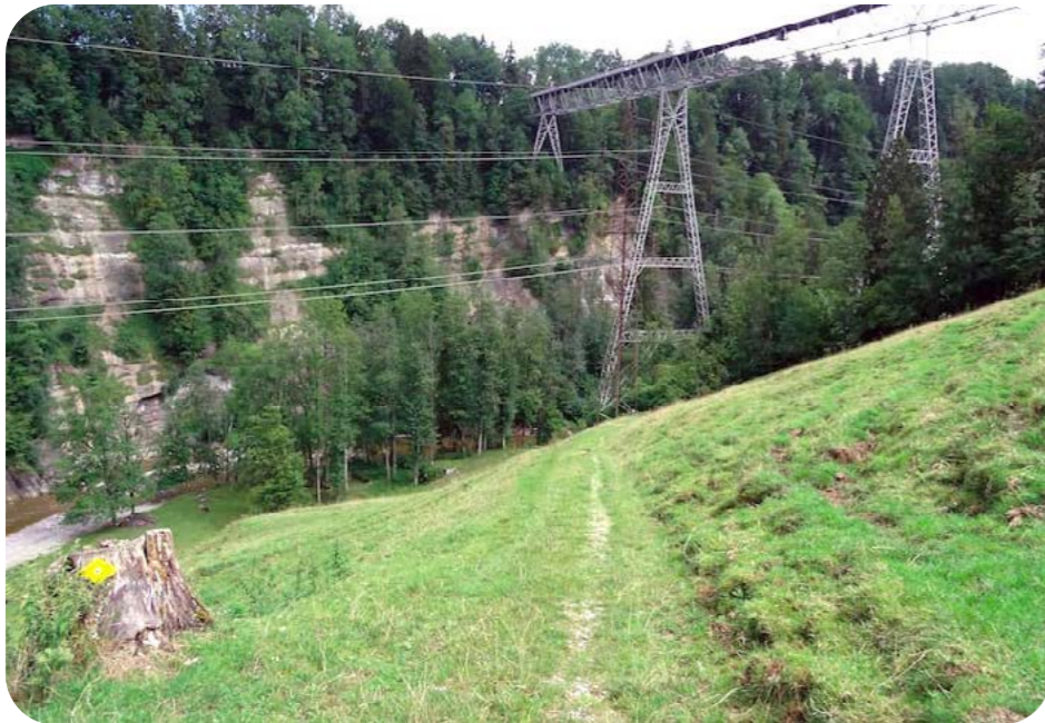
↑ ↑ Der Hängesteg im Rechen (1882) ist ein eleganter Zeitzeuge der Ingenieurskunst des 19. Jahrhunderts. (Foto: GSI Architekten)
