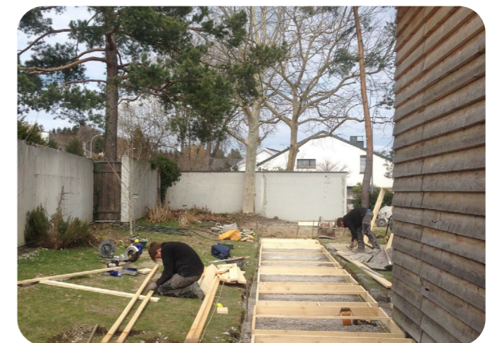
↓ Vorher (Foto: GSI Architekten)
