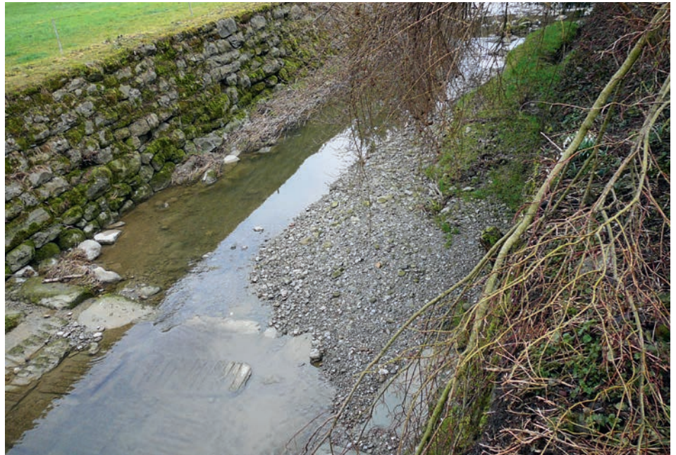
Gstaldenbach mit zu geringer Wasserführung. Hier fliesst nichts mehr.
